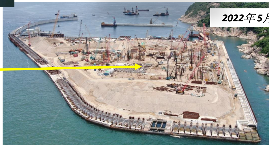
海堤和碼頭沉箱+3.0mPD 以上結構施工
