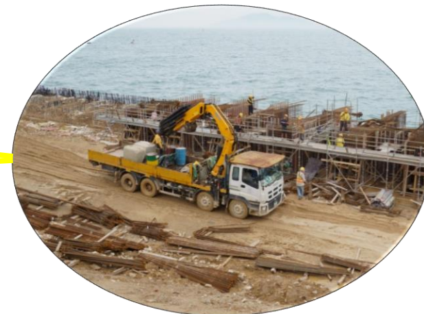
海堤和碼頭沉箱+3.0mPD 以上結構施工
