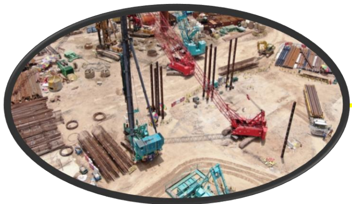
地基打樁施工
