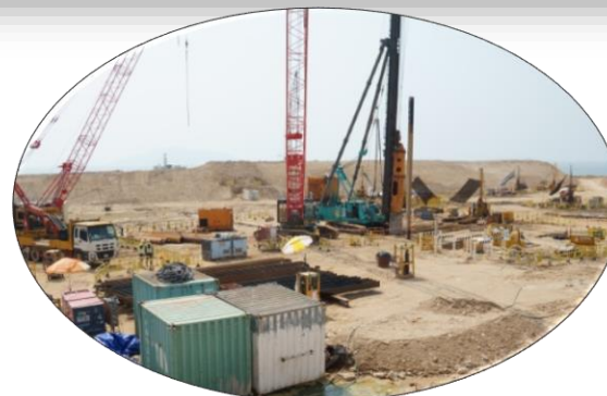
地基打樁施工
