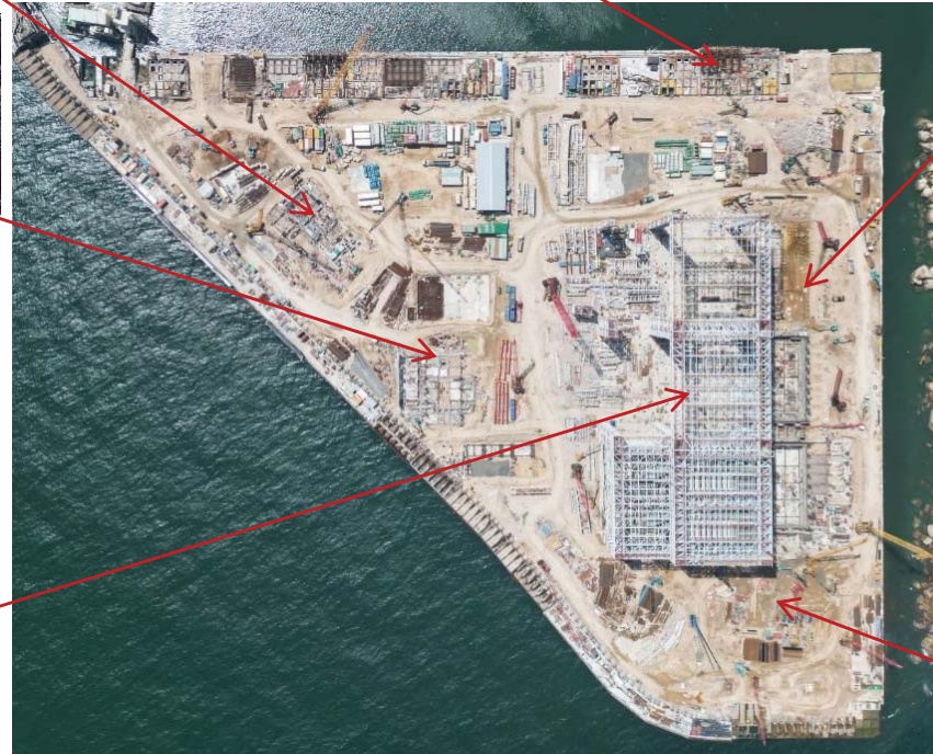
主焚化爐大樓鋼結構及 鍋爐組件安放
